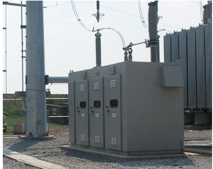
13.8 KV – 3 ÉTAPES AVEC RÉACTANCES
